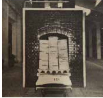
Fotoğraf 11: İstanbul Porselen fabrikası, Fırın bölümü, 1984 (Kaynak: Şişecam Dergi Arşivi) Image 11: Istanbul Porcelain Factory, Firing Studio, 1984 (Source: Şişecam Magazine Archive)
