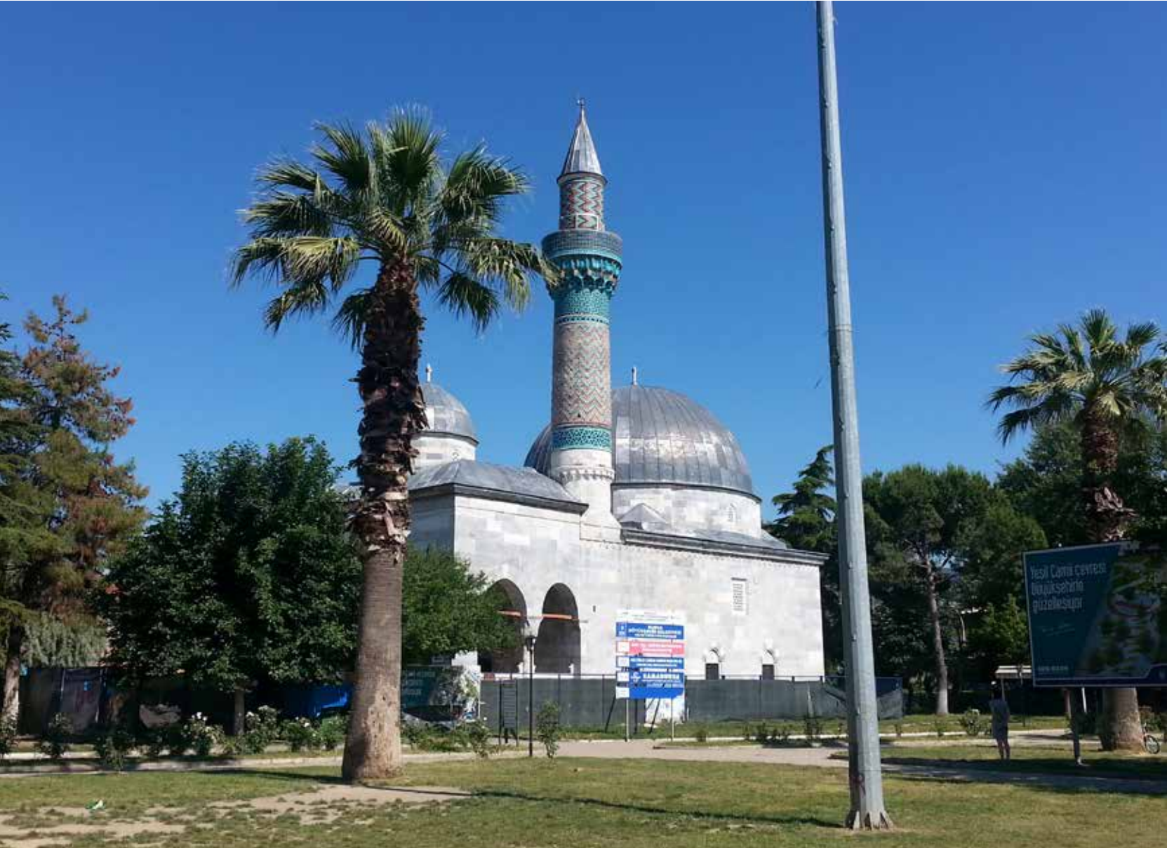
Cami restorasyon montajı sonrası- After restoration of mosque
