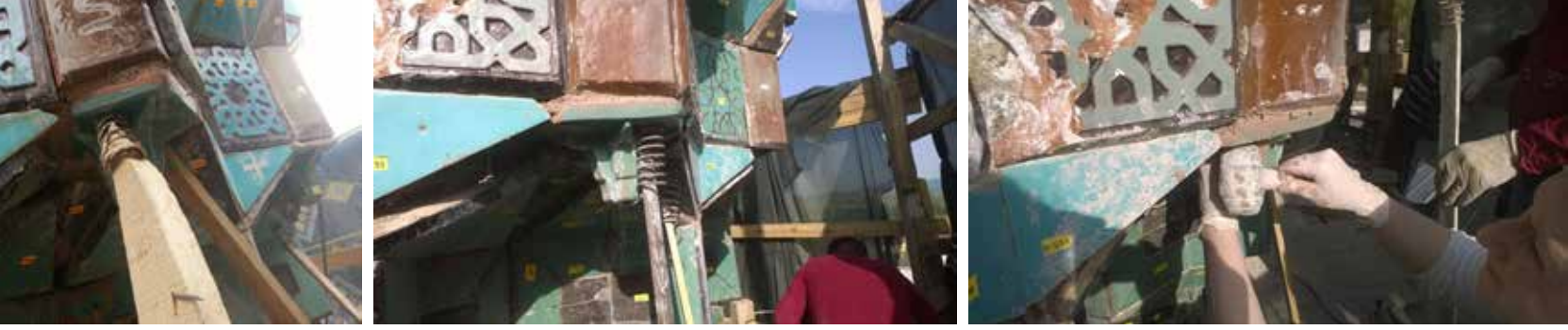
Cami restorasyon montajı yapılırken - During restoration of mosque
