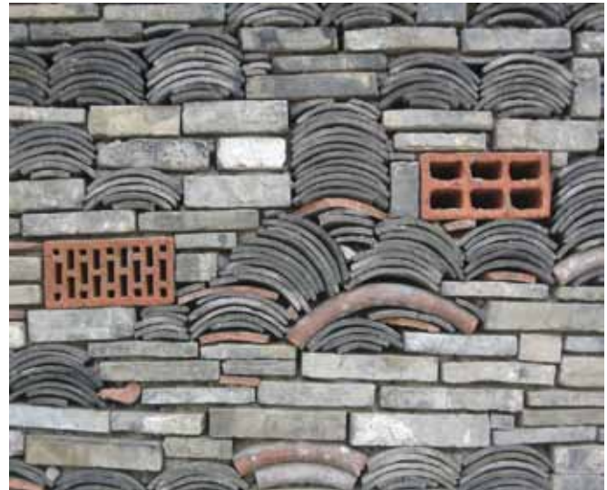
Wa pan duvar detayı / Wa pan wall detail
