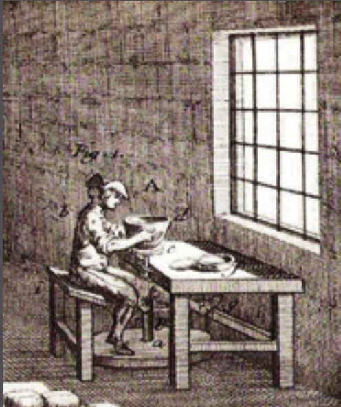
Resim 7. 18. asırda Fransa'da, demir aksı olan, ayakla döndürülen merkez-kaç kuvveti ile çalışan bir çömlekçi tezgâhı görüntüsü.
