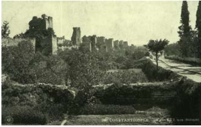
"Les murs aux 7. tours" (Yedikule Surları) diye tanımlamasına rağmen, aslında Silivrikapı yakınındaki surları göstermektedir. Although described as "Les murs aux 7. tours" (Yedikule Walls) Actually shows the walls in the proximity of the Gate of Melanthias.
