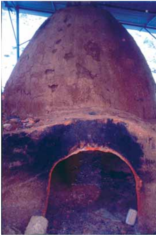
Resim 6 Fırının ocaklık kapısının görüntüsü Picture 6 View of hypocaust gate of the kiln
